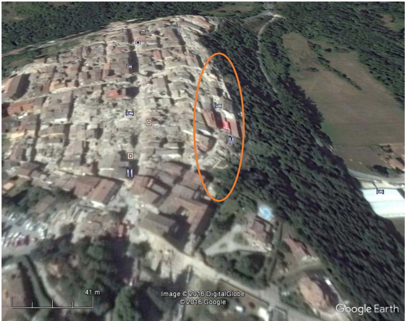
Fig. 7: Amatrice, vista dall'alto. La zona circolettata è sul culmine del dosso. La scossa sismica è stata particolarmente violenta in tali condizioni, come prevedono le NTC 2008, (coefficiente S_T ).
